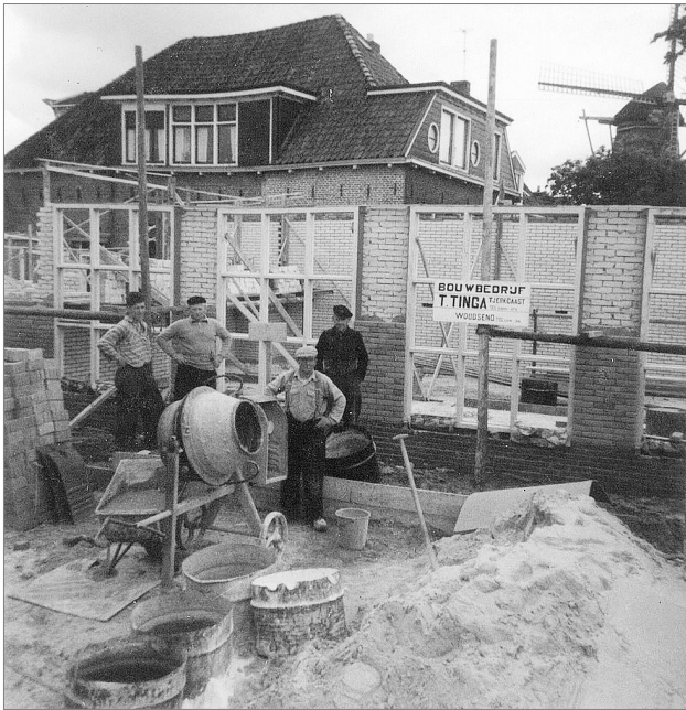
De drukkerij aan het Julianaplantsoen in aanbouw (1960)
