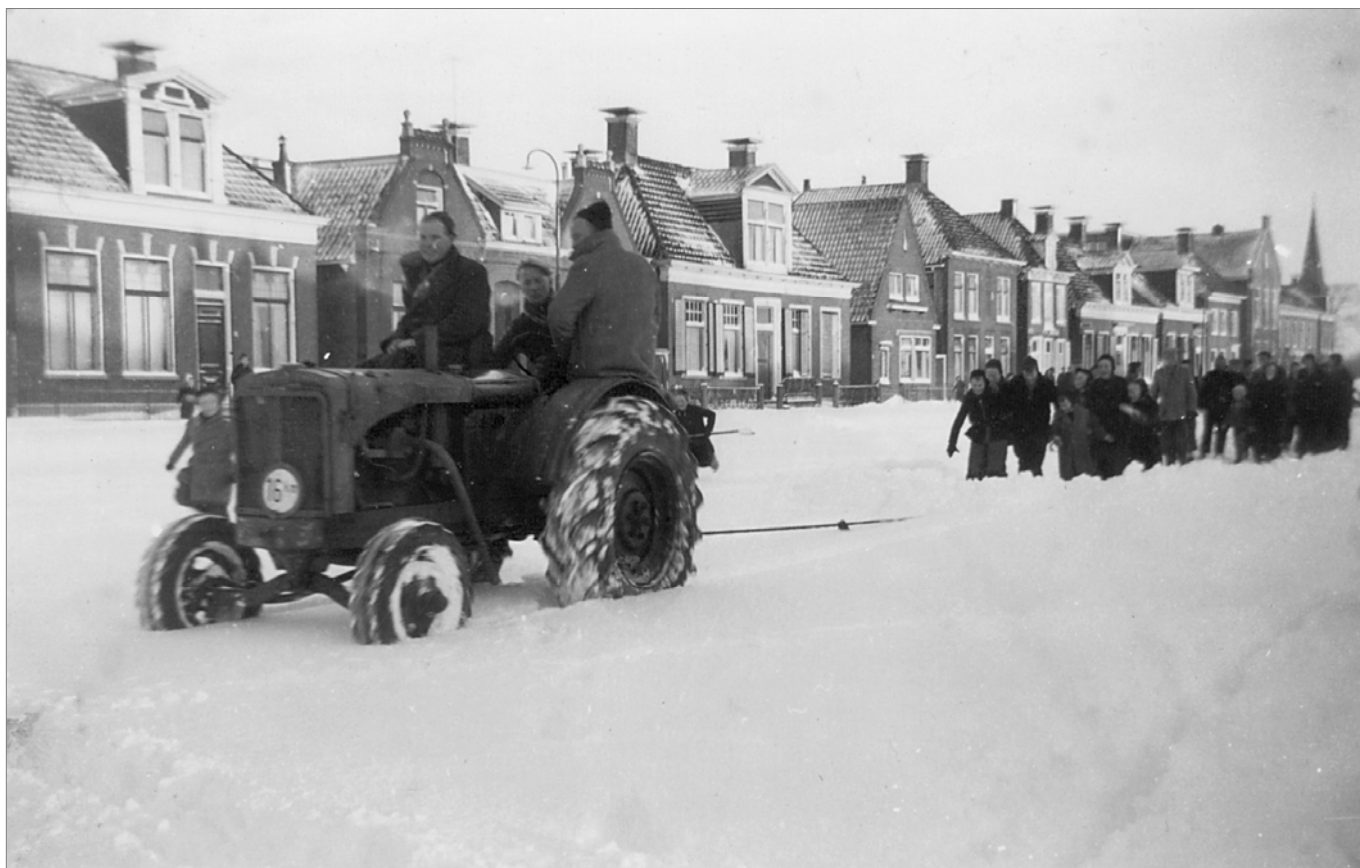
Onder grote belangstelling wordt met een trekker en sneeuwschuiver een baan over het ijs van de Ee gemaakt.
